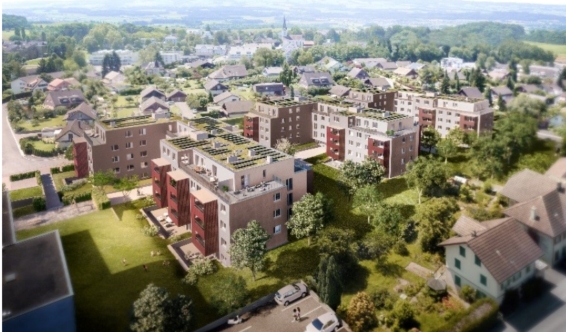
Abbildung 12: Siedlung Sentmatt, Obfelden: Der Strom aus den Hybridkollektoren wird für den Betrieb der Wärmepumpe und für den Allgemeinstrom im Eigenverbrauch genutzt. Bildquelle: Halter Immobilien AG
